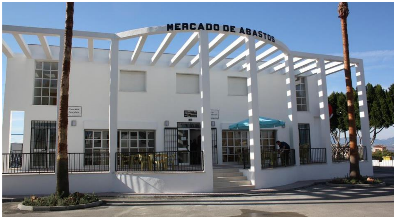
Figura 119. Exterior del Mercado de Abastos de Alhaurín el Grande
